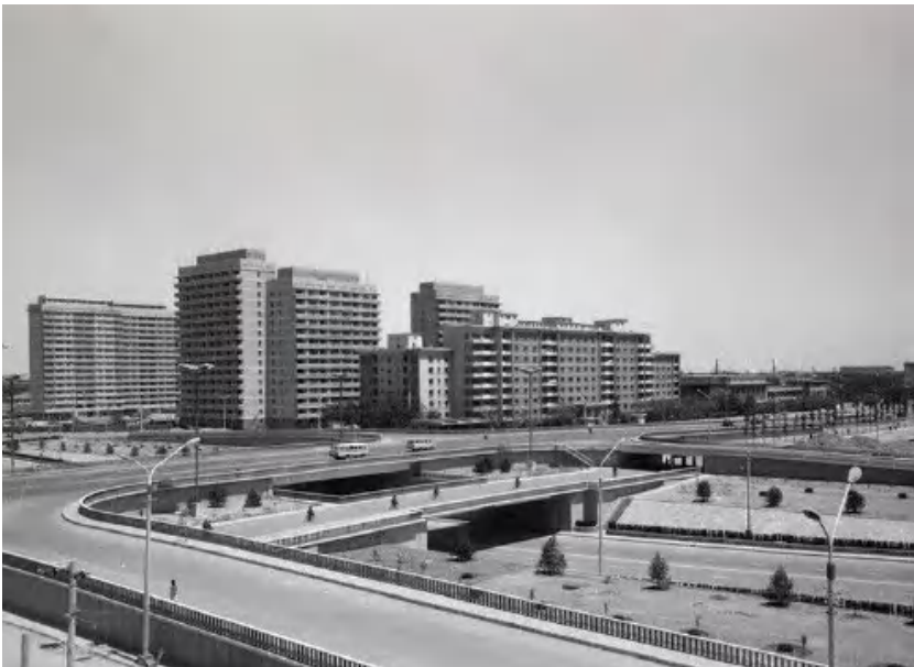
图：1978 年建国门立交桥 Jianguomen Overpass in 1978.
